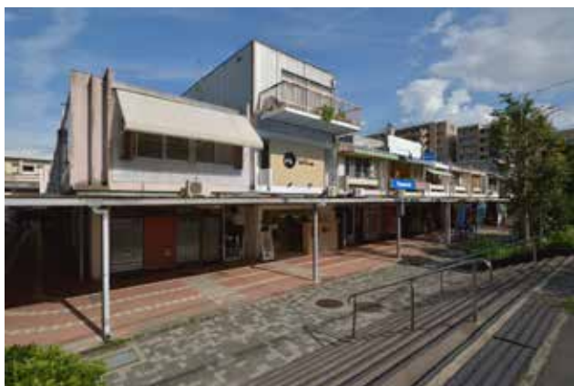
(写真 4-3) 新千里東町近隣センター
