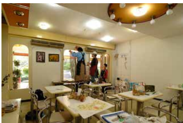
(写真 4-25) 移転作業の様子
