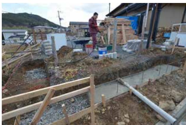
(写真 5-34) 屋外にキッチンを建設
