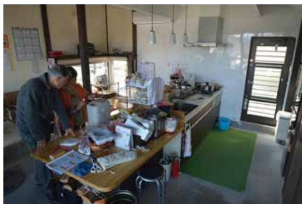
(写真 7-6) 設置された勝手口
