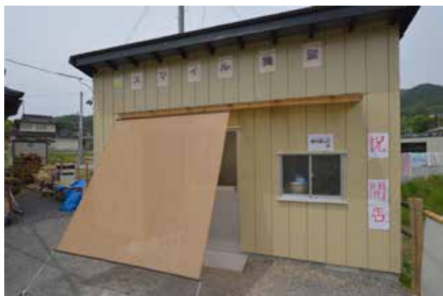
(写真 5-24) 屋外に建設したキッチン
