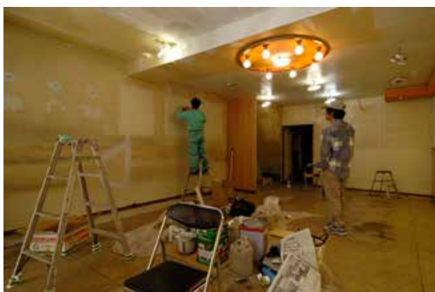
(写真 4-23) 移転作業の様子
