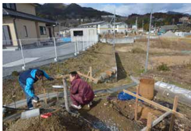
(写真 8-16) 「居場所ハウス」屋外に建設中の食堂
