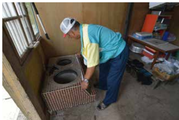
（写真 8-20）個人宅にあったカマドを移設・修復し 屋外のキッチンスペースに設置
