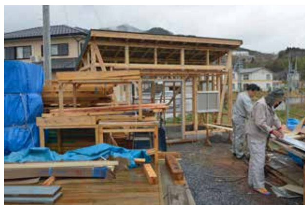
(写真 5-35) 屋外にキッチンを建設
