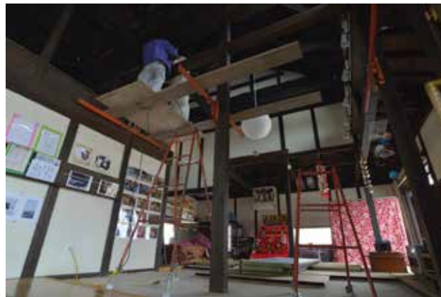
(写真 7-2) 「居場所ハウス」における 柱の撤去作業
