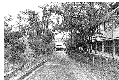
写真6 歩行者専用道路と近隣センター (正面の建物)
