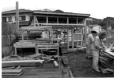
写真8 屋外のキッチンの建設
