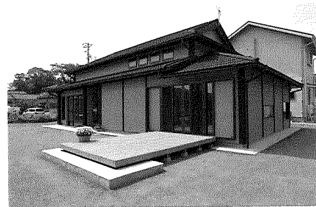
写真1 「居場所ハウス」外観
