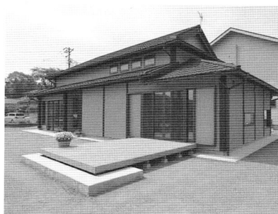
写真1 古民家を移築・再生した建物
