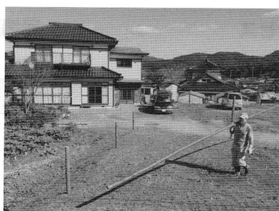
写真19 法面の安全柵のための竹を搬入
